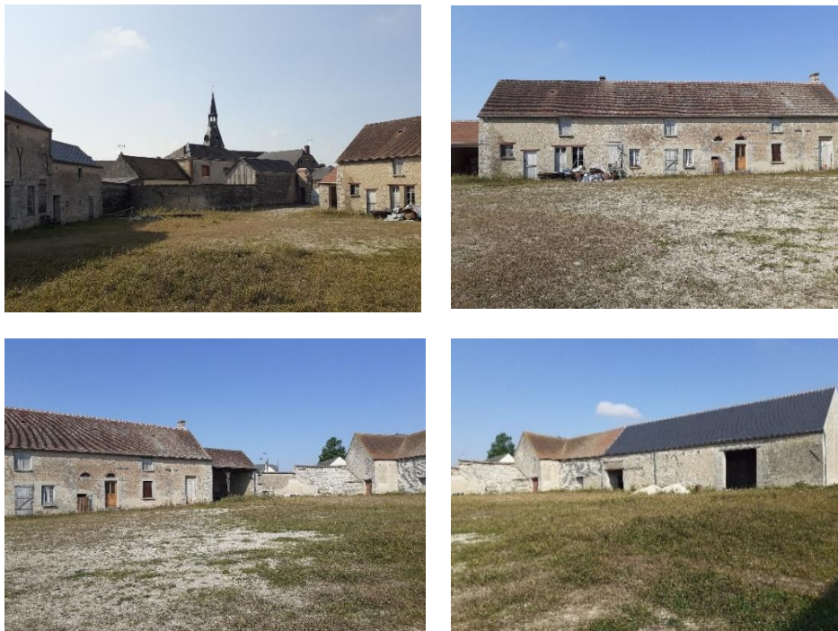
FIG 2 : Visuels avant travaux de la friche bâimentaire de la Blaveterie
